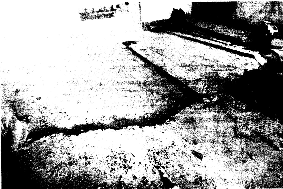
Fig. 2: Demolición de Pisos (e=0.05 m).
