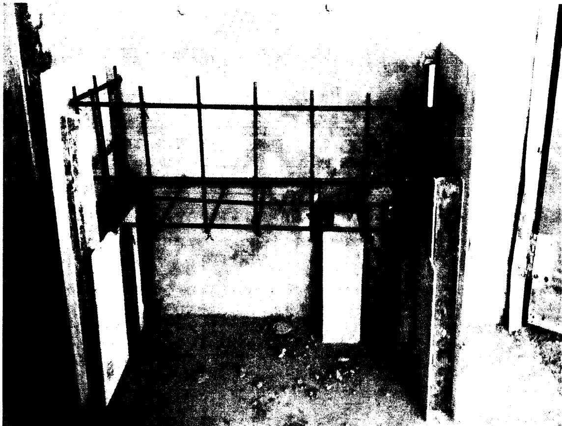
Fig. 26: Apilamiento y Encofrado de Maniluvios.
