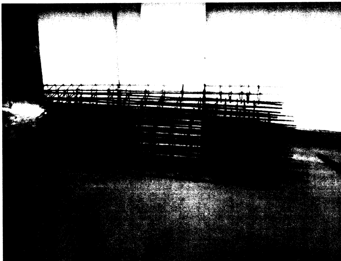
Fig. 10: Armaduras de Columnas para su Anclaje.
