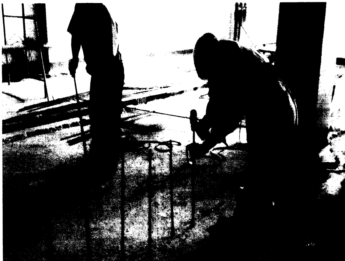
Fig. 8: Anclaje de Aceros Verticales para Sobrecimiento Nuevo.
